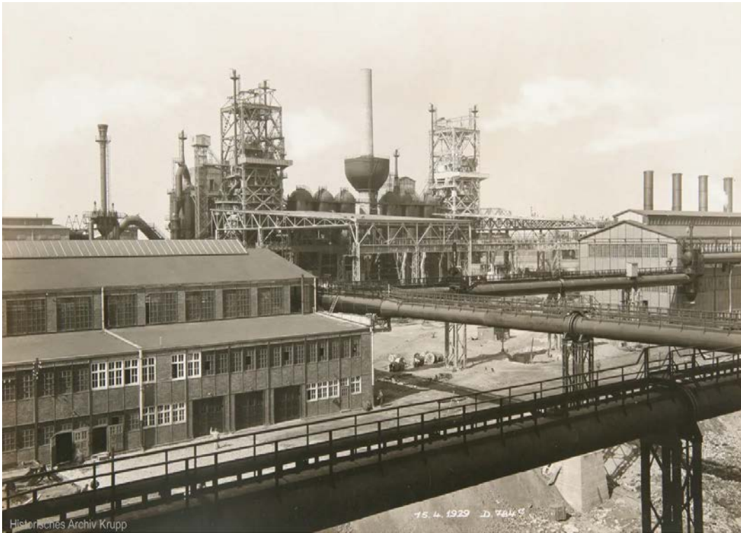
Krupp, Hochofenanlage des Hüttenwerks Essen-Borbeck, 1926
