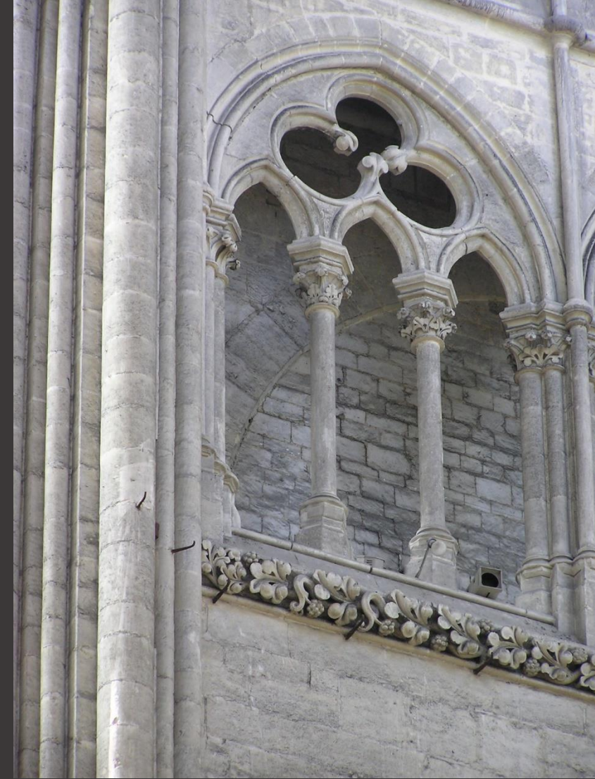
Amiens: Triforium mit Masswerk, teilweise mit Fenstern in der Rückwand
