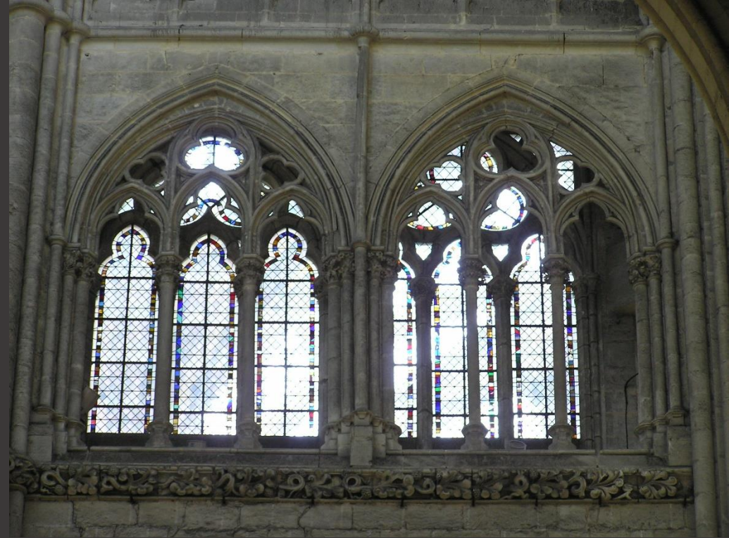
Amiens: Triforium mit Masswerk, teilweise mit Fenstern in der Rückwand
