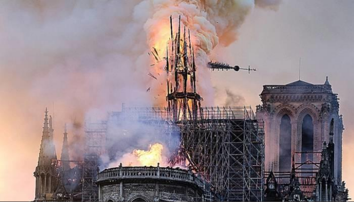
Zerstört: Dachreiter von 1860
