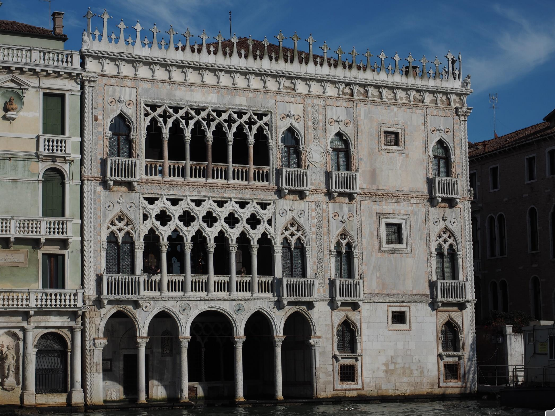
Venedig, Ca D'Oro, Fassade 1425-1431 durch Matteo Raverti und Giovanni Bon
