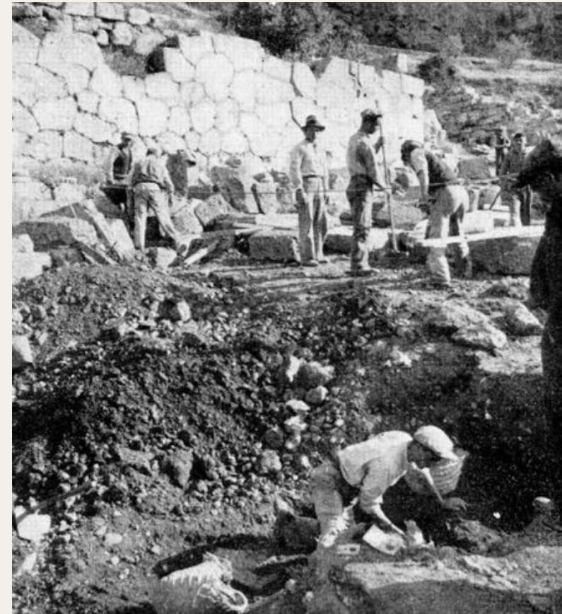
Dépavage de la voie sacrée au sud du temple d'Apollon, 1939
