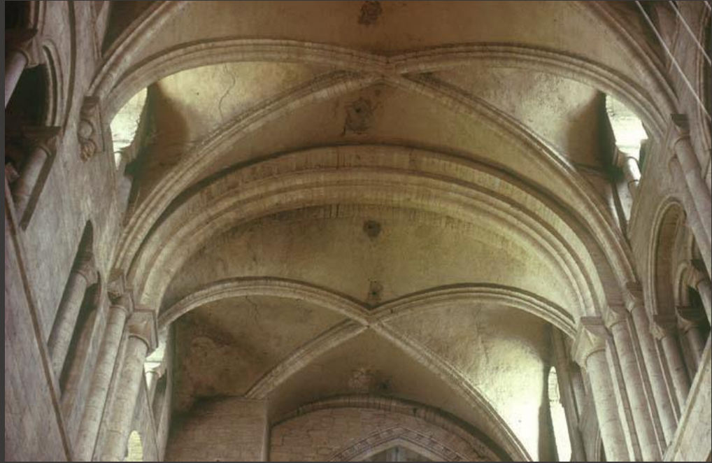
Rippengewölbe | voûte d'ogive (avec nervures) : um 1100 an verschiedenen Stellen Europas entwickelt. Normandie (Lessay, Caen); England (Durham – rechts) Oberrhein (Speyer, Bandrippen | nervures à profil rectangulaire – links)
