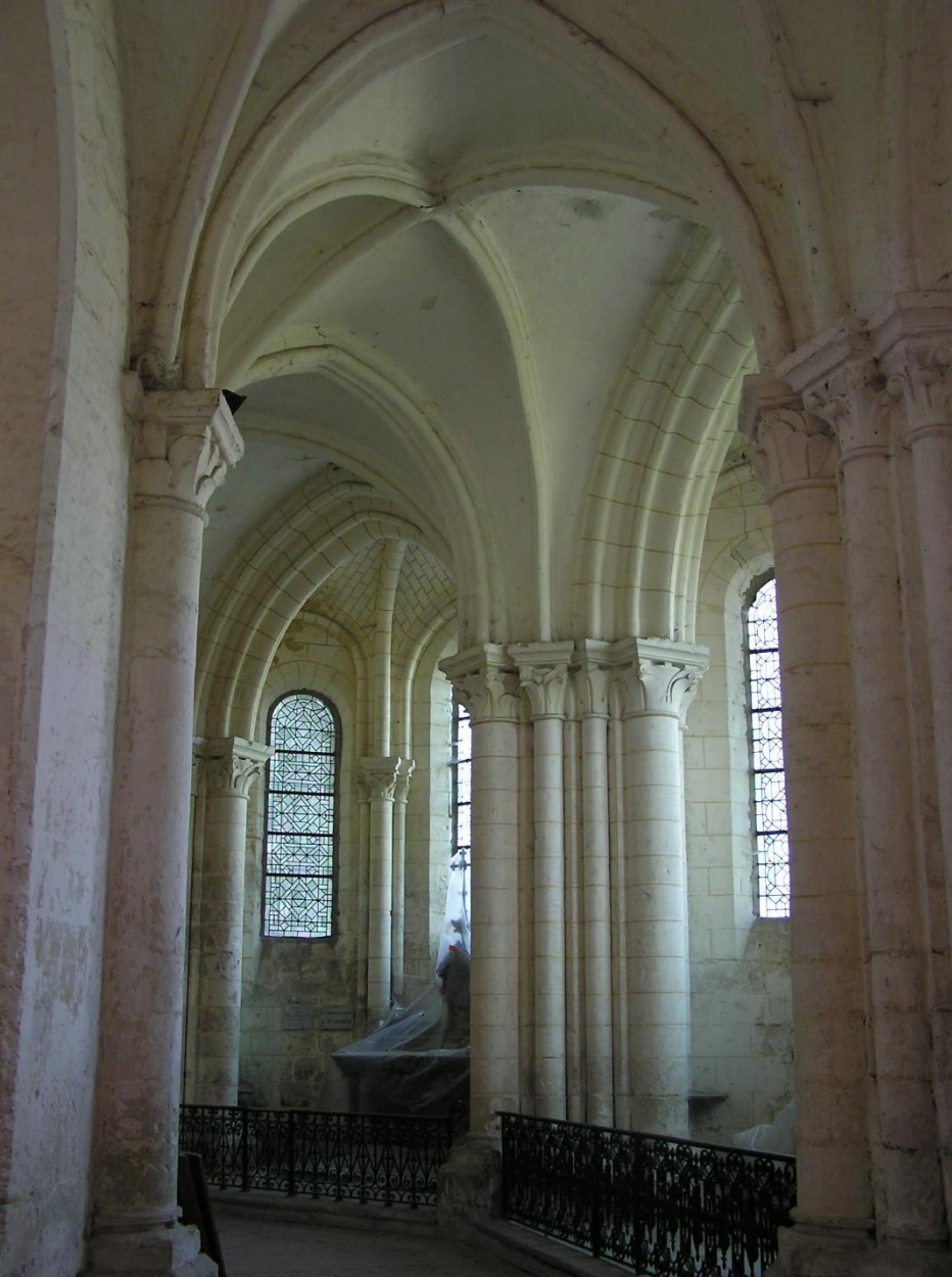
Chorumgang | déambulatoire mit Rippengewölbe und vorbereitendem Dienst- Apparat an den Bündelpfeilern
