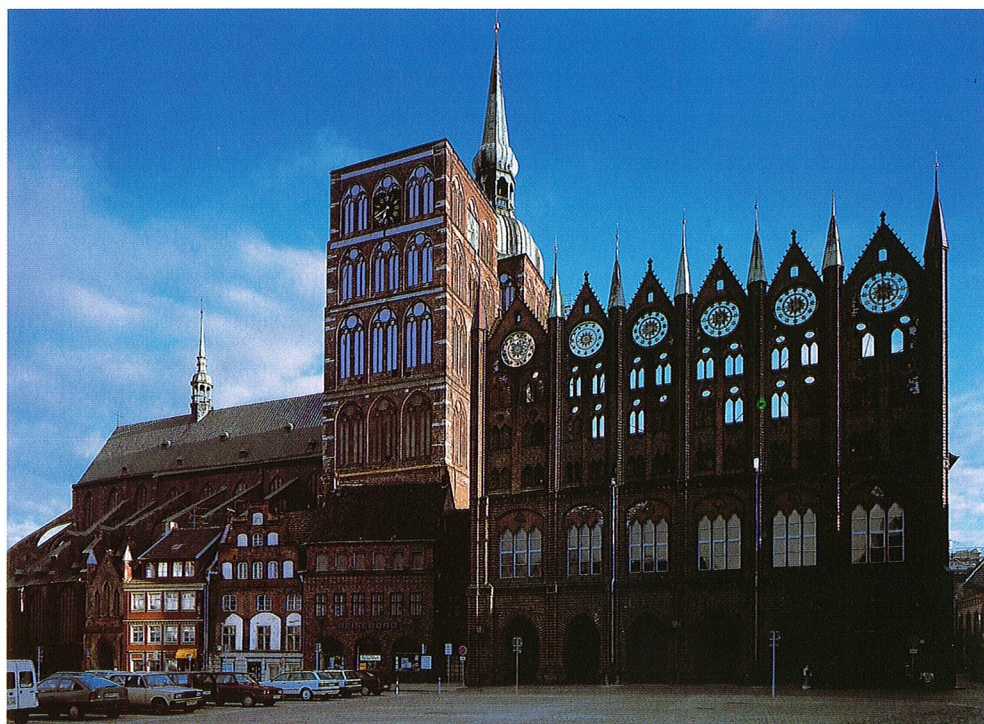
Abb. 9 Stralsund, Markt, Nikolaikirche und Rathaus von Norden, 1. Hälfte 14. Jahrhundert. Der Schildgiebel und die Lang- seite der Nikolaikirche bilden eine gestaltete Platzwand, als deren kompositorische Mitte der nördliche Westturm der Kirche fungiert. Bild: Florian Monheim, Neuss.
